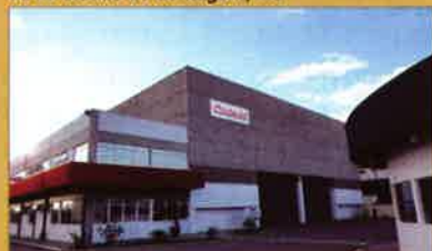
Fig. 35. Fachada da Combustol Fornos, localizada na cidade de Jundiaí, SP
