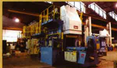
Fig. 36. Forno Elétrico Automático Batch-Modelo "RTQ" (Stihl Ferramentas Motorizadas)
