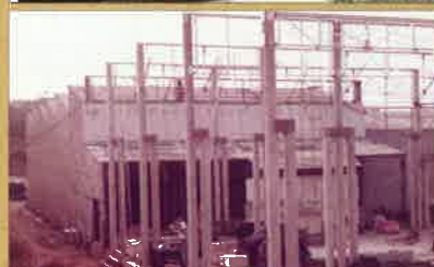
Fig. 10. Construção da unidade matriz em 1964
