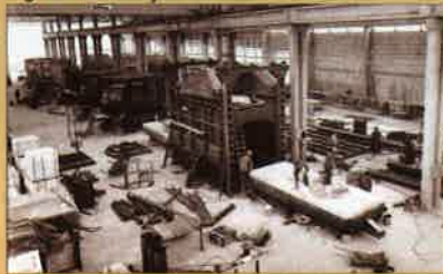
Fig. 11. Fábrica de fornos da Combustol já no novo endereço em 1964
