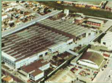
Fig. 26. Foto aérea do Grupo Combustol/Metalpó em São Paulo, SP
