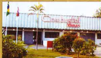
Fig. 34. Fachada da Combustol Minas, localizada na cidade de Contagem, MG
