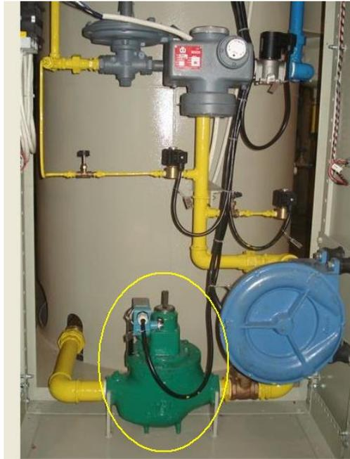
Válvula “shut-off” para bloqueio de alimentação de gás em caso de ocorrência de qualquer irregularidade no Gerador
